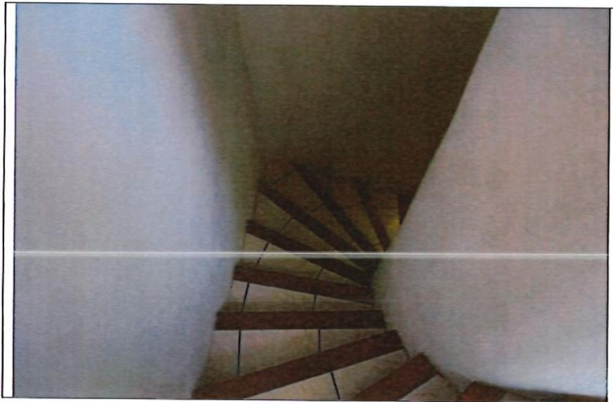
Le sous-sol est accessible par un escalier maçonné tournant situé dans la cuisine. Celui-ci a ses nez de marches composés en bois. Les contremarches sont à l'état brut de maçonnerie. Les marches sont carrelées.
